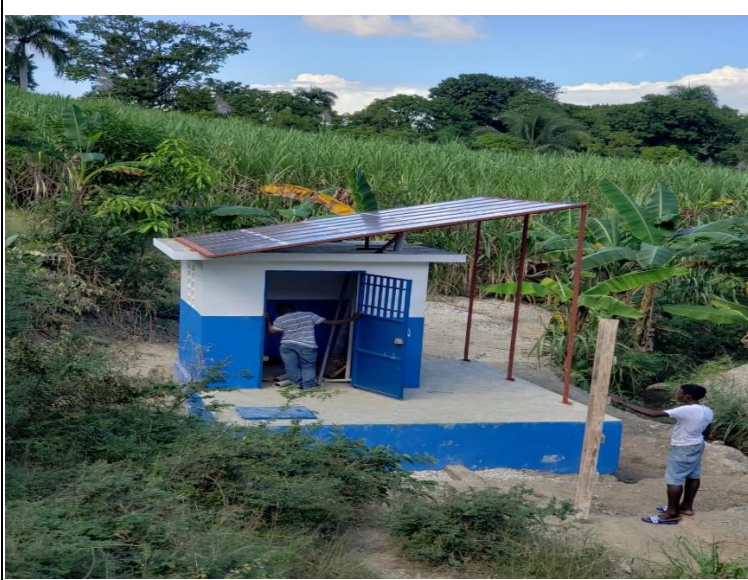
Grand Boucan – Boite captage, Système d'adduction d'eau potable
